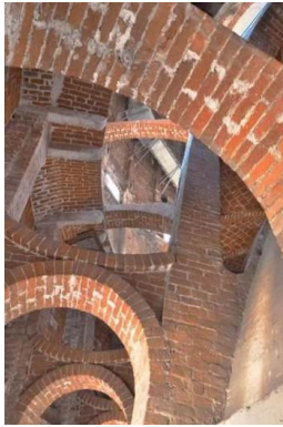
Successione di archi e archi rovesci nello spazio curvo di intercalottatura della cupola. Schema raffigurante la partizione del cielo e la suddivisione dello spazio terrestre secondo l'aruspicina etrusca.
